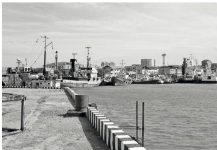
Среди проблем порта — отсутствие стивидорной службы и недостаточное техническое оснащение
