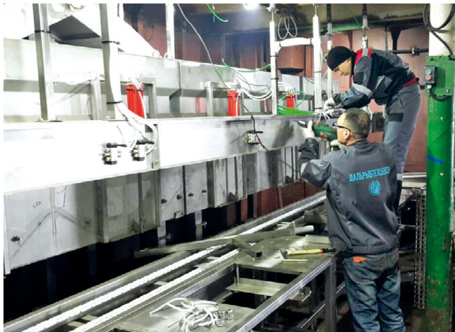
Монтаж технологического оборудования на судне компании «Антей»
