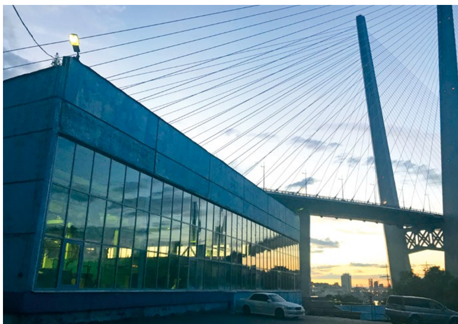
Пожар на строящемся мосту через бухту Золотой Рог едва не стал причиной трагедии для «Дальрыбтехцентра» в 2011 году
