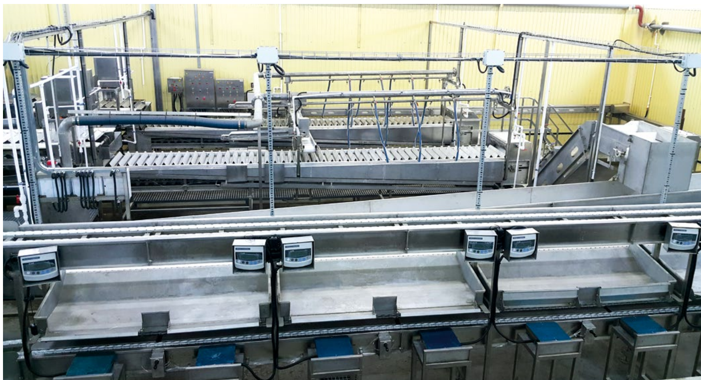
В этом году «ДРТЦ» приступает к монтажу второй очереди завода для ООО «Заря»
