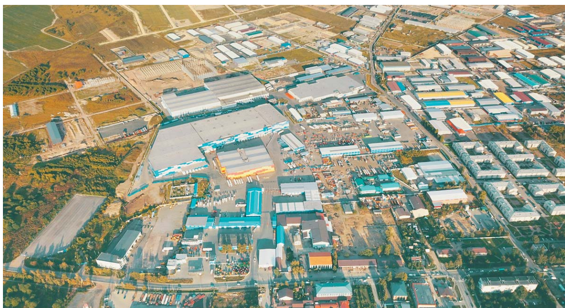
Мультитемпературный комплекс класса «А+» расположен на территории в 60 га недалеко от автомагистралей, железнодорожного терминала и морского порта
