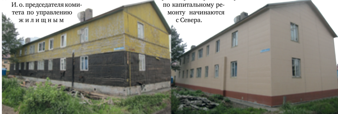
▲ Оссора, ул. Лукашевского, дом 92. Капитальный ремонт фасада
