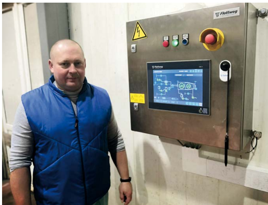
Локальная панель управления Flottweg
