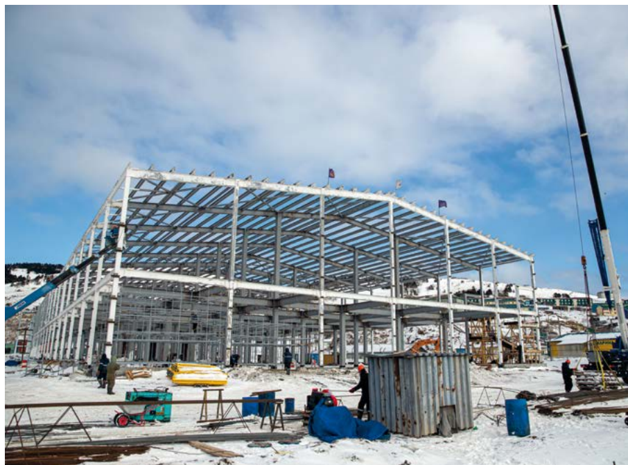
Строительство нового завода Рыбокомбината «Островной» на острове Шикотан идет полным ходом
