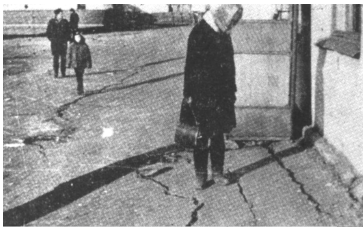
Трещина в асфальте и грунте на территории морского порта
