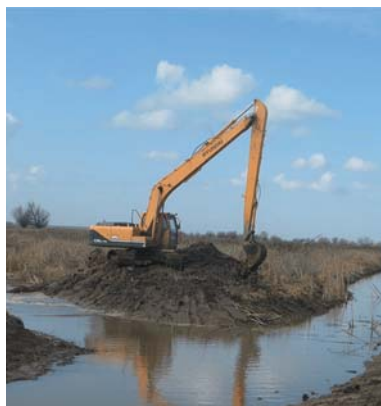
Расчистка, углубление водопроводящих и сбросных каналов от заиливания и наносов песка и грунта
