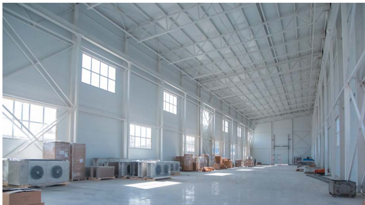
На заводе «Гран» три производственных цеха. Четвертый (на фото) — на финальной стадии стройки
