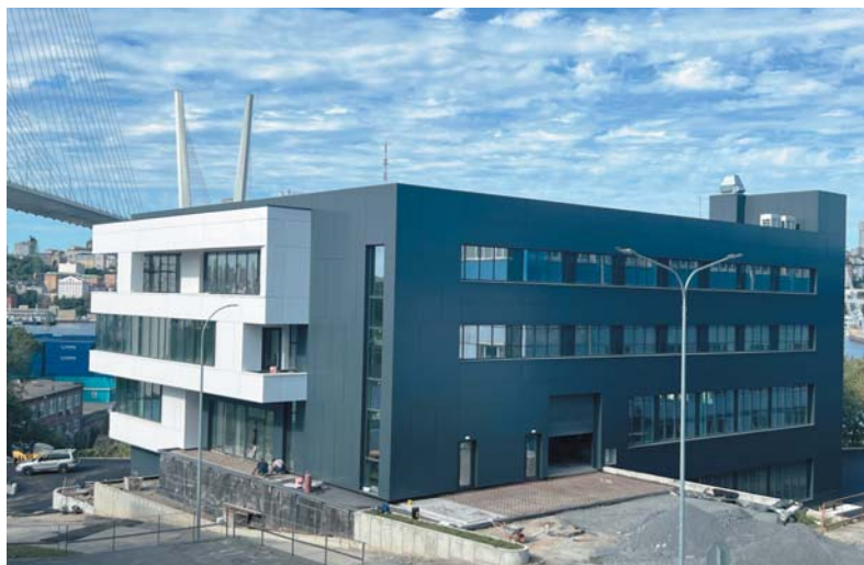
Новый корпус «Дальрыбтехцентра» у Золотого моста. Проект позволил расширить рабочие площади на 3600 кв. метров и преобразить панораму Владивостока
